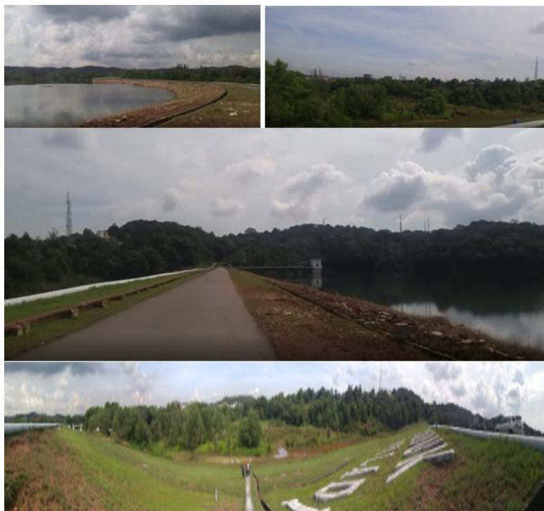
Gambar 3. Kondisi Eksisting Waduk Sei Ladi
