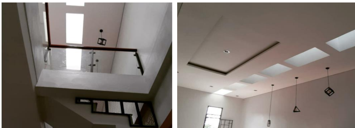
Gambar 6. Penggunaan Skylight Pada Rumah Tinggal (Sumber : Peneliti, 2021)
