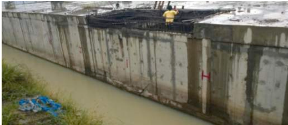
Gambar 5. Bangunan Reservoir yang Sudah Berada di atas Permukaan Tanah
